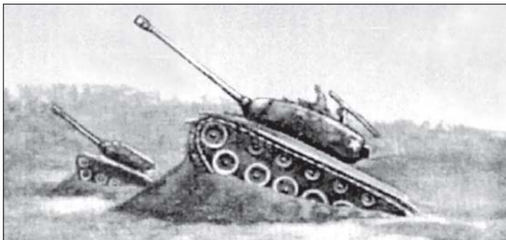
Применение земляных аппарелей для танков, стреляющих с закрытых позиций
